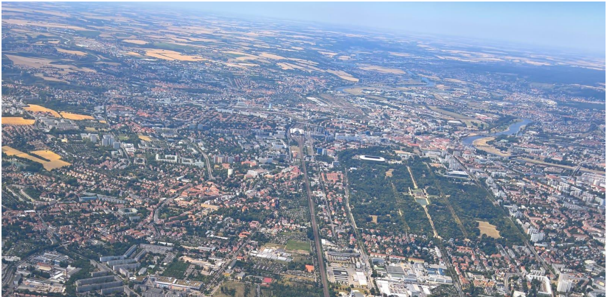
Bild 3: Viele Kader genossen erstmalig den tollen Blick auf Dresden
